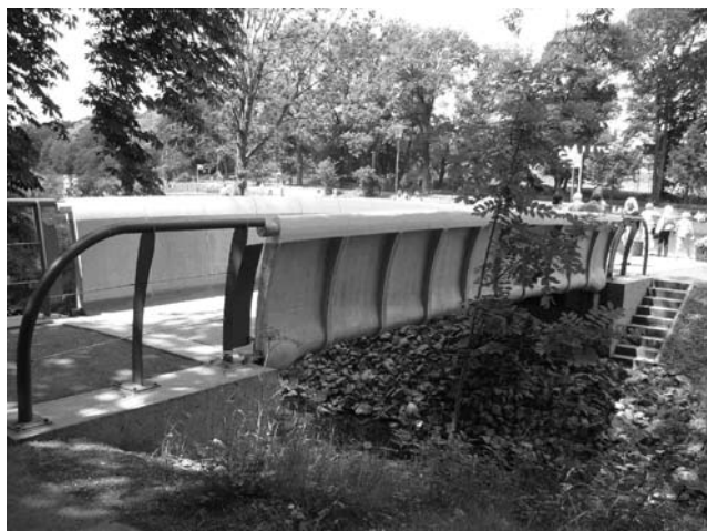
Abb. 2 Textilbetonbrücke auf der Landesgartenschau 2006 in Oschatz
